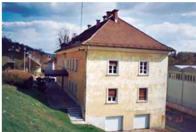
PŠTO Gorenjske v Kranju. V objektu je bilo priročno skladišče orožja in streliva.
