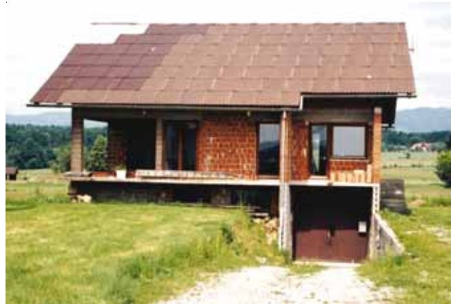
Novogradnja Jožeta Staniča, Župelec 12, Kapele, ki je hranil orožje in strelivo OŠ MSNZ občine Brežice
