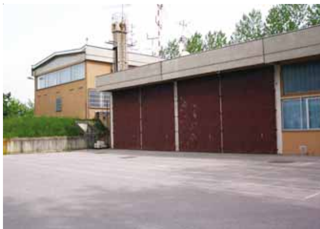
Skrivno skladišče orožja, streliva in minskoeksplozivnih sredstev v Gasilskem domu Grosuplje
